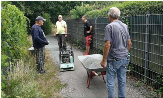
Bild 35: Verdichtung der Wegedecke
