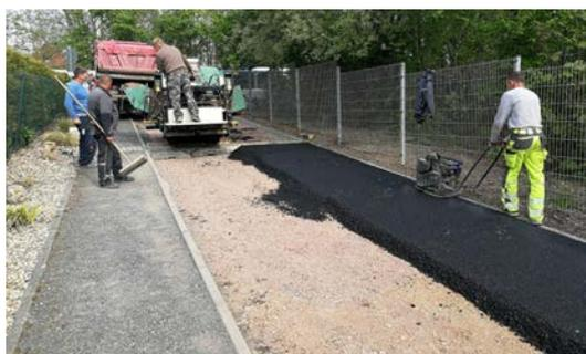
Bild 31: Fertigung neuer Bitumendecke
