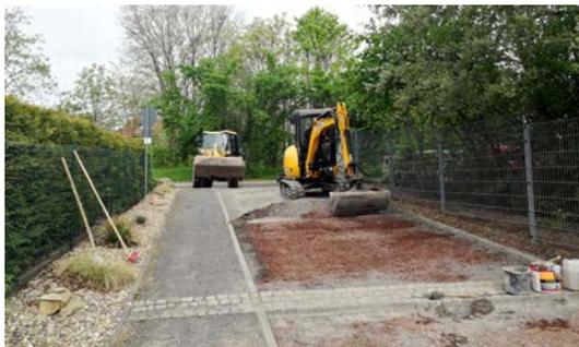
Bild 30: Die alte Belagdecke wird ausgebaggert
